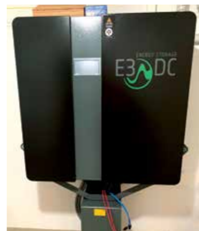
Die PV-Anlage auf dem Hausdach wird durch einen Speicher sinnvoll ergänzt
